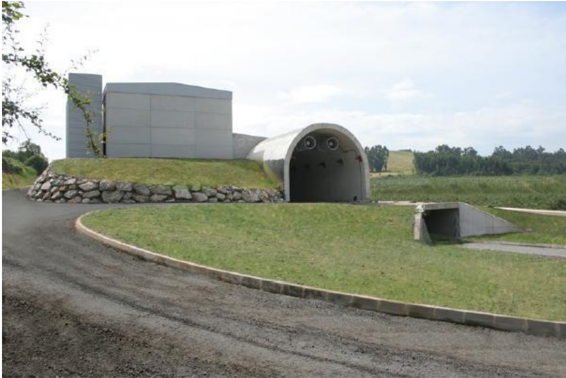
Boca norte, estación de ventilación y galería inferior de emergencia
