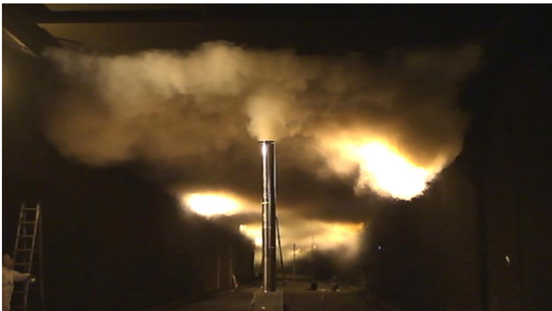
Máquina de humo trabajando en el Túnel Experimental de San Pedro de Anes
