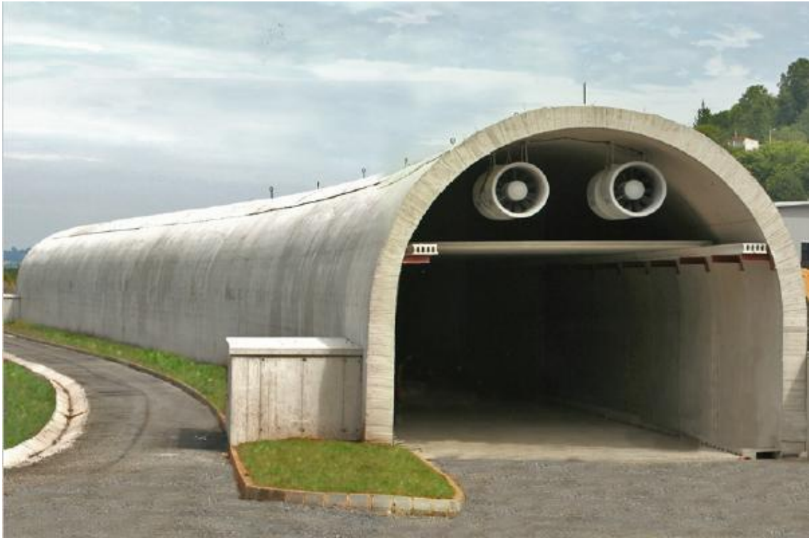
Boca sur del túnel con falso techo instalado y ventiladores de chorro
