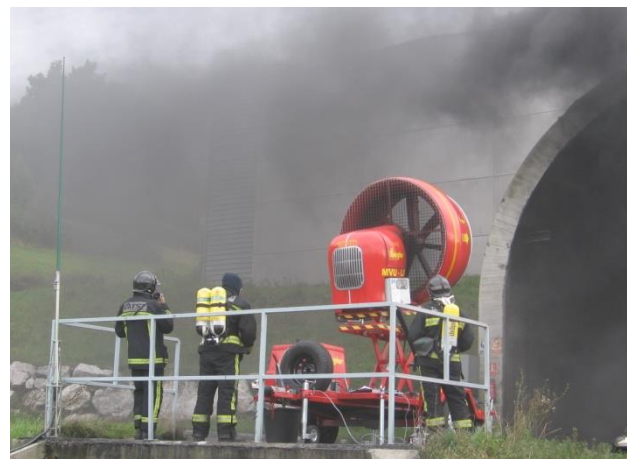
Simulacro con ventilador móvil de gran caudal
