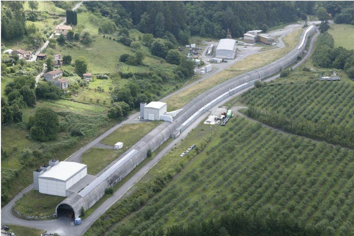
Vista general N-S del túnel de ensayos
